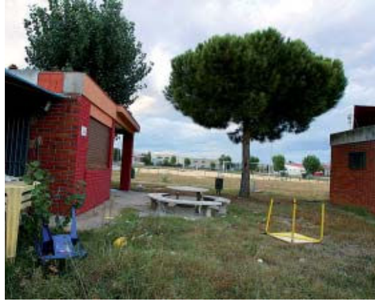
L'antic camp de futbol de la Ferreria està força deteriorat | SANTI ROMERO
